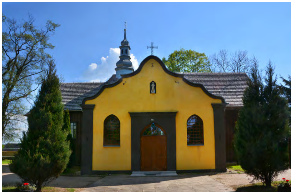
Elewacja północna, murowana kaplica z 1869 r.
