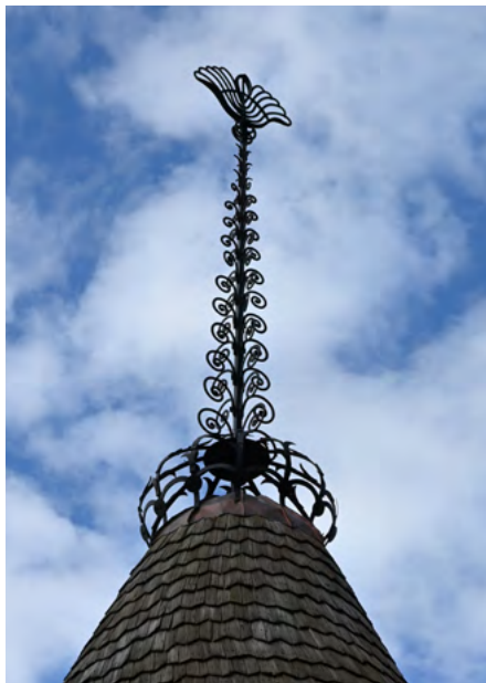
Zwieńczenie dachu dawnego przystanku tramwajowego
