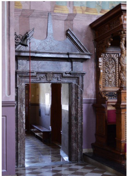
Barokowy portal (wejście do zakrystii)
