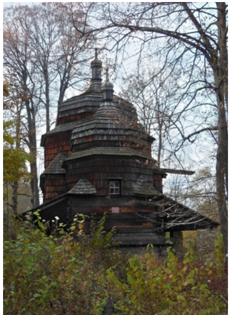
Elewacja wschodnia, prezbiterium
