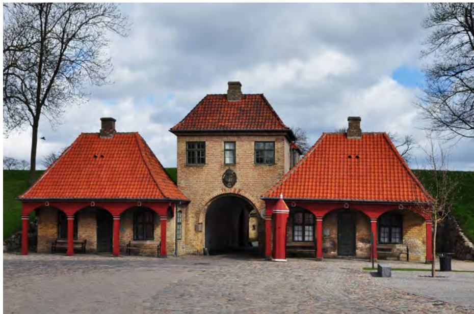
Brama północna (Norweska), elewacja południowa
