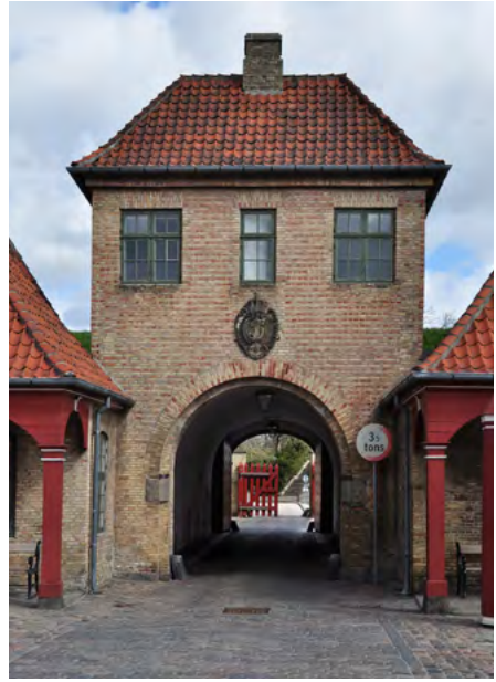
Brama północna, elewacja południowa
