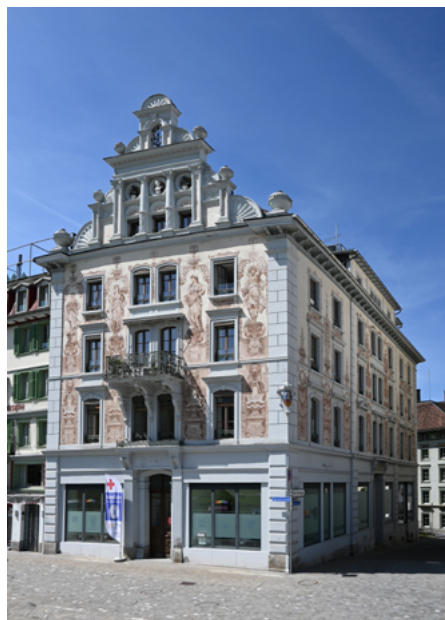
Fasada (elewacja wschodnia)
