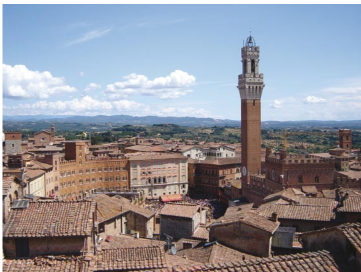
Piazza del Campo i wieża przy Palazzo Pubblico
